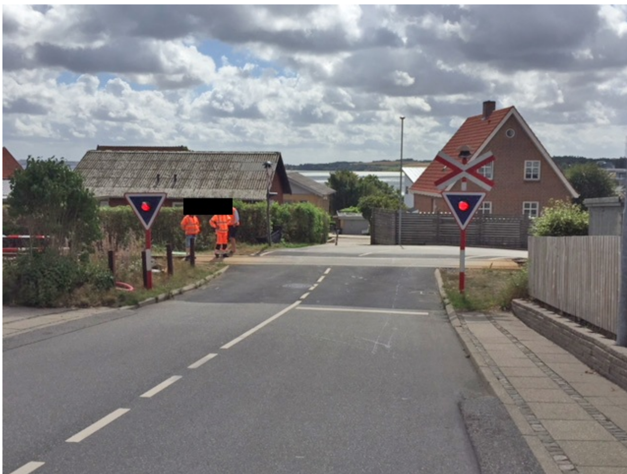
Overkørsel 265 set i retning fra Hundborgvej 10.08.2018
