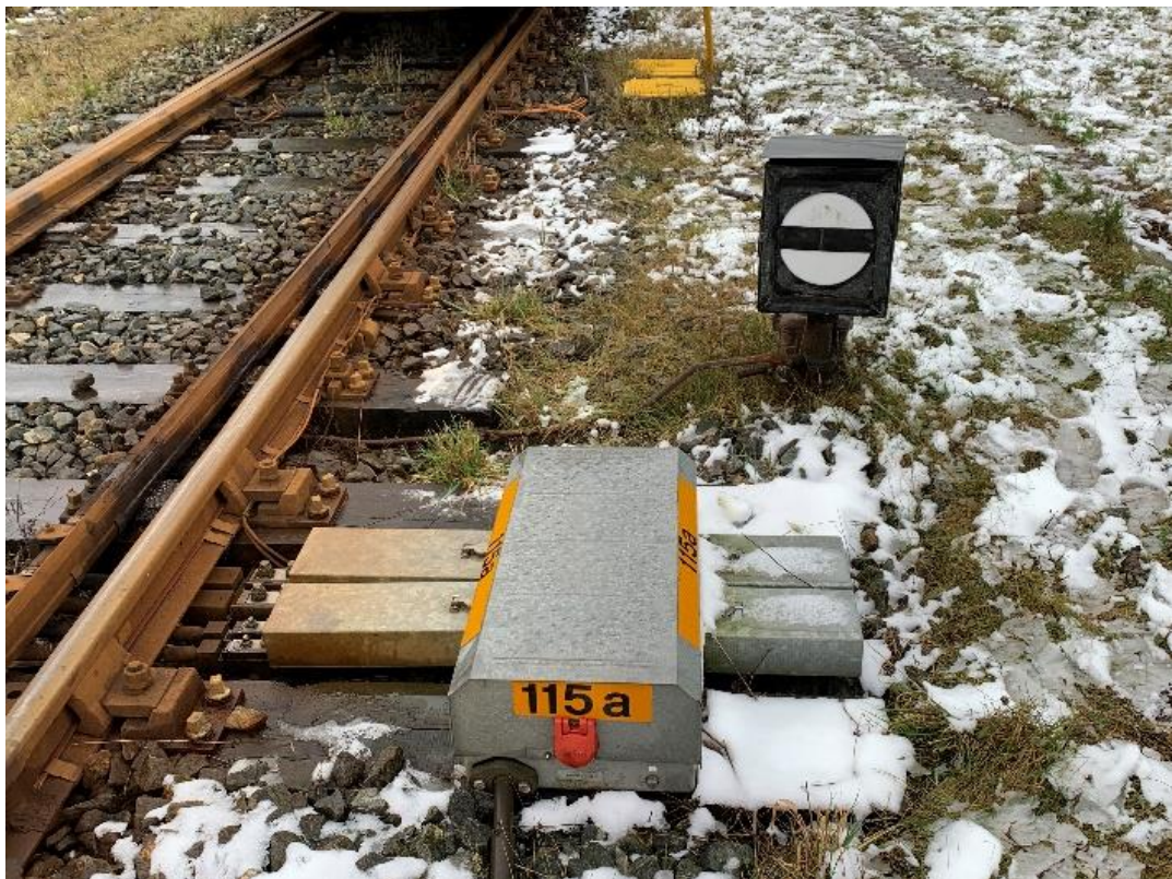
Sporskifte 115a stod efter afsporing i højre gren/afløb, sporspærresignalet bag sporskiftedrevet viste ligeledes, at sporskiftet var sat til afløb. Foto: Arriva.
