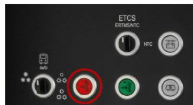
LTT "Anlæg fjederbremse" Lyser ved fuld anlagt fjederbremse
